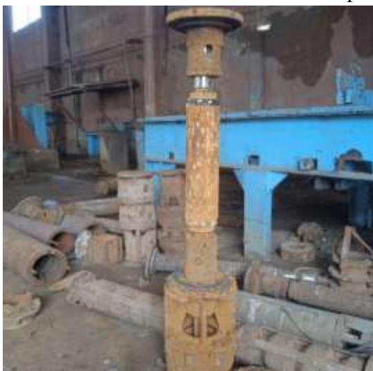
2-расм. ЭЦВ 10–160–35 тик қудуқ насосининг металл конструкцияси коррозияга учраган ҳолати.
