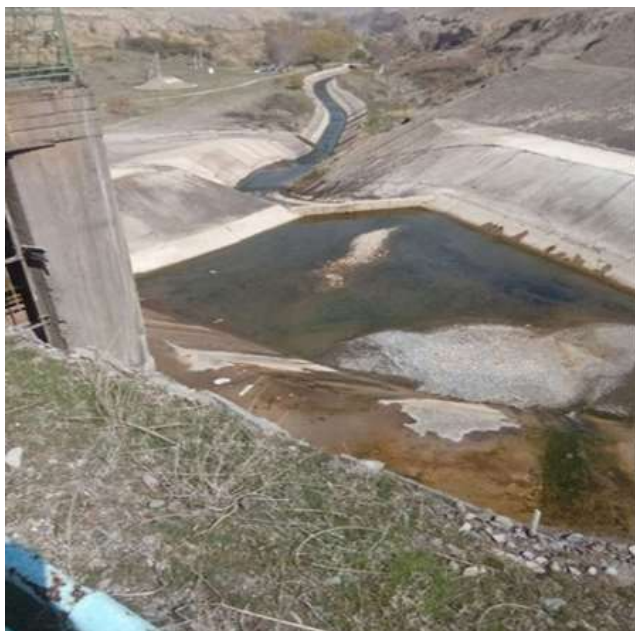
Рис.2.Водосброс Каркидонского водохранилища.
