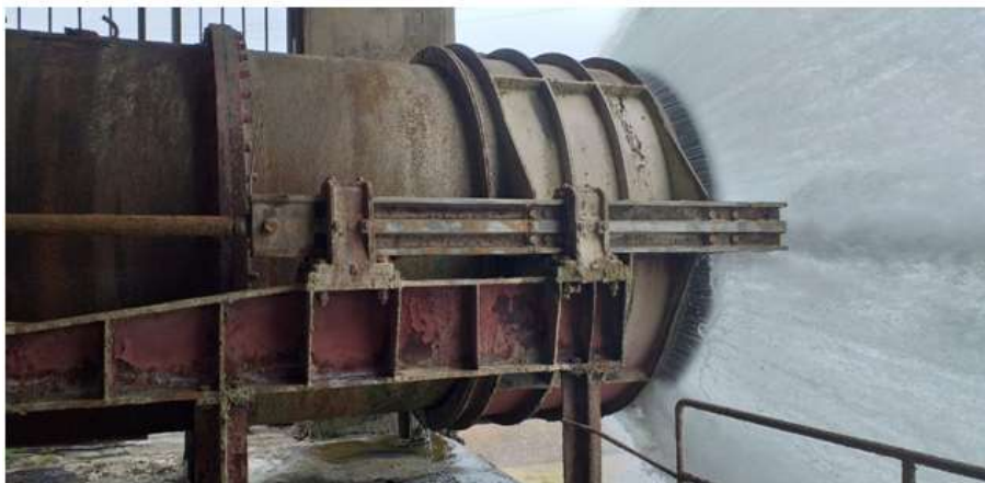
Рис.1 Вовлечение газа со свободной поверхностью водосброса.
