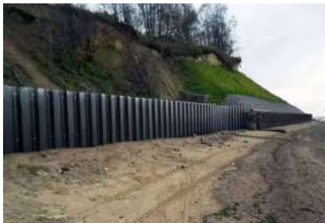
4-Расм. Темир йўлларни кўчкдан муҳофаза қилувчи замонавий мосламалар.
