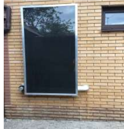
Рис. 1 Вид солнечного воздухонагревателя.
